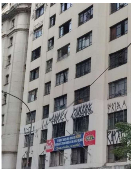
Imagem 1 - Fachada da Ocupação Martins Fontes com faixa em prol da luta por moradia. Fonte: Acervo das autoras, 2025.
